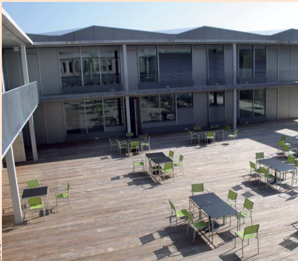
Здание IUCN Conservation Center, головной офис международной организации International Union for Conservation of Nature (IUCN) в городе Гланд (Швейцария), спроектирован в соответствии со швейцарскими стандартами экологического строительства – Minergie – P, регулирующими рациональное использование энергии и возобновляемых энергоресурсов, и Minergie – Eco, регламентирующими аспекты «зеленого» строительства и дизайна. Здание претендует на получение платинового сертификата LEED
